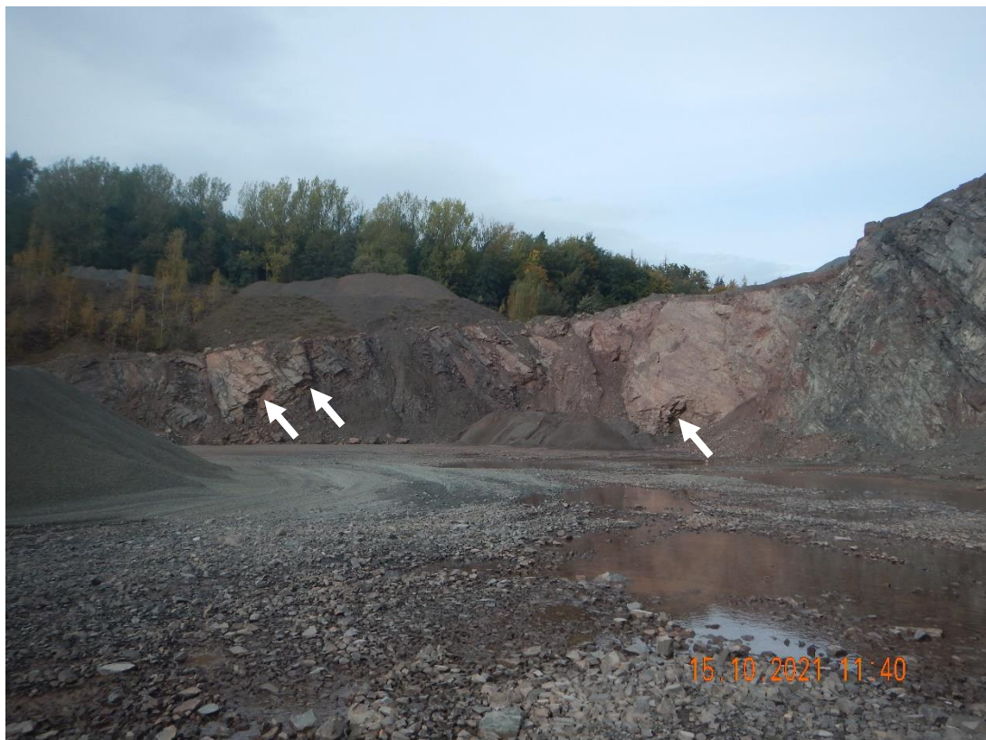
Abbildung 6: Wandbildend aufgeschlossene und geneigt in Richtung Süden bzw. Südosten einfallende Trennfläche im nördlichen Böschungssystem (4. Sohle). Lokal sind Kluftkörper bzw. Kluftkörperverbände von unten frei geschnitten (weiße Pfeile).
