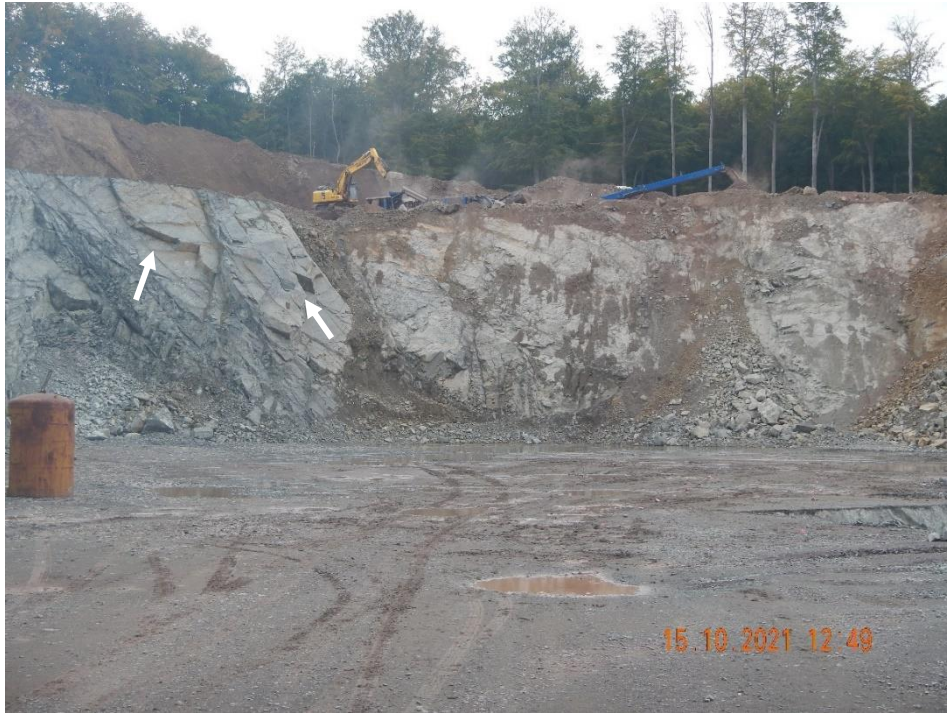
Abbildung 11: Großflächig bzw. wandbildend in Richtung des Tagebaus einfallende Trennflächen im Verschnitt von Süd- und Westböschung (3. Sohle). Die weißen Pfeile verweisen auf von unten frei geschnittene Kluftkörper(verbände). Entlang der Westböschung waren lokal Vernässungsstellen zu beobachten.
