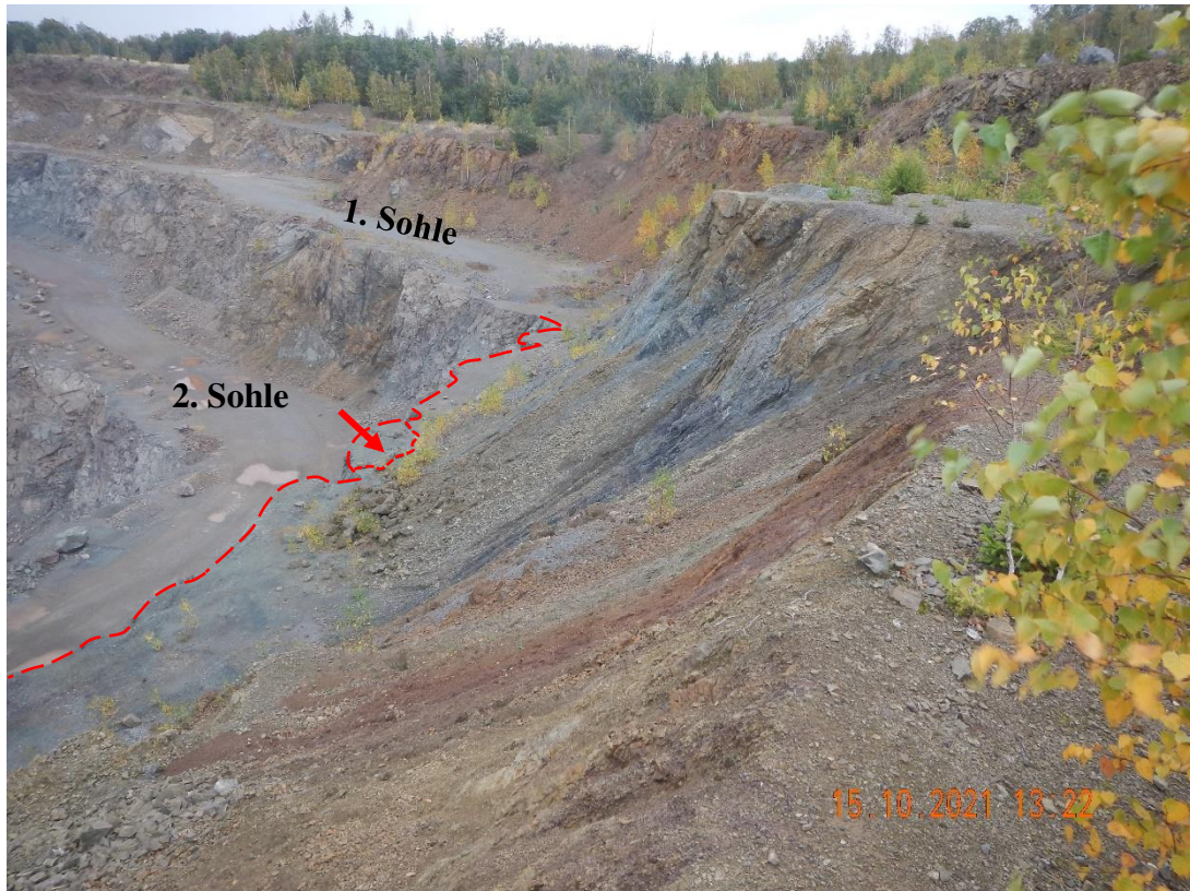
Abbildung 15: Blick nach Osten entlang der gezackten Konturen der 1. Sohle im südlichen Böschungssystem. Der rote Pfeil verweist auf einen vom umliegenden Gebirgsverband (teilweise) gelösten Block bzw. Pfeiler. Es besteht weiterhin Abbruchgefahr.
