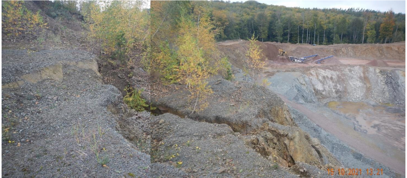
Abbildung 13: Risse, welche entlang der Geländeoberkante des südlichen Böschungssystems über mehrere Meter Streichlänge und bis zu 10 m im Hinterland der Böschungsschulter verfolgt und z. T. um mehrere Dezimeter geweitet sind, sowie Absenkungen an der Geländeoberkante des südlichen Böschungssystems. Der vom umliegenden Gesteinsverband bereits tlw. abgelöste und mit Birken bewachsene Block ist akut abgleitgefährdet. Blick in Richtung Westen.
