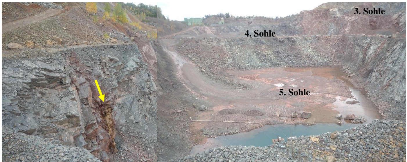
Abbildung 5: Blick nach Norden in die 5. Sohle. Am linken Bildrand befindet sich eine Wasseraustrittsstelle (gelber Pfeil).
