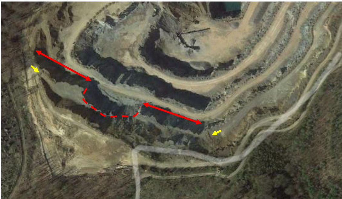
Abbildung 2: Digitales Orthophoto (DOP) vom April 2021 [U 7]. Der Rutschungsbereich ist rot gestrichelt umrandet und umfasst eine Streichlänge von etwa 90 m. Westlich und östlich des Verbruches sind weitere kleinere Abbrüche vorhanden (rote Pfeile). Im Oktober 2021 festgestellte Risse entlang der Geländeoberkante bzw. der 1. Sohle deuten darauf hin, dass sich die Böschung kurz- bis mittelfristig weiter umbilden wird und mit weiteren Abbrüchen zu rechnen ist. Die gelben Pfeile verweisen auf abgelegte Freisteine als Schutz gegen ein Befahren der 1. Sohle des südlichen Böschungssystems.
