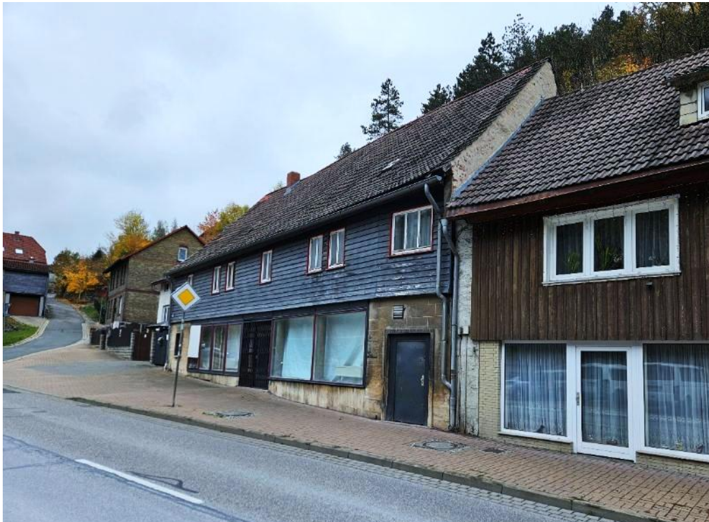
Abb. 29: Leerstehende Wohngebäude in Rübeland (Stadt Oberharz am Brocken, Landkreis Harz); Quelle: eigene Aufnahme der CIMA.
