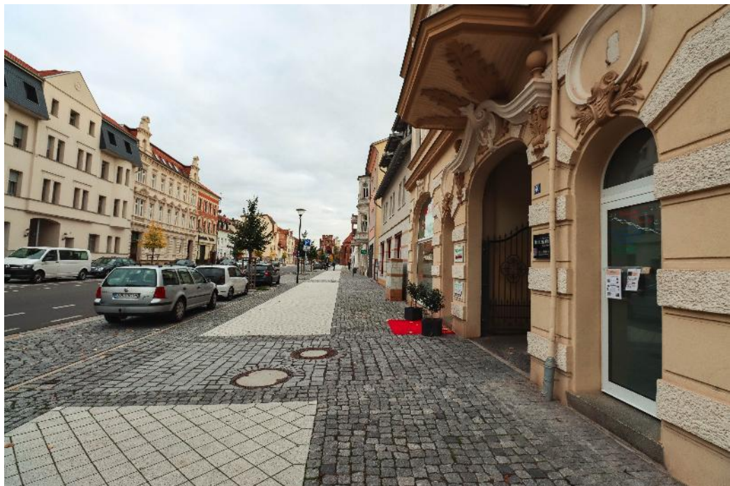
Abb. 15: Innerstädtischer Wohnungsbestand in Stendal mit einer Mischung aus historischen und modernisierten Gebäuden – exemplarisch für die vielfältigen Bestandsstrukturen in Sachsen-Anhalt; Quelle: Ministerium für Infrastruktur und Digitales des Landes Sachsen-Anhalt.
